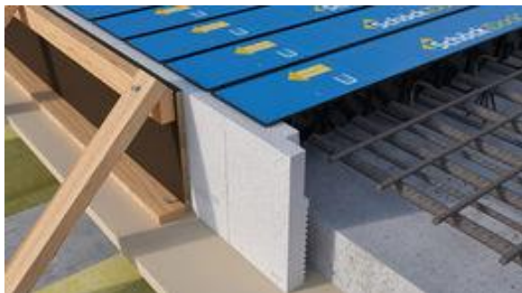
Innsettelse av kant og utsparingselement i armeringen.
